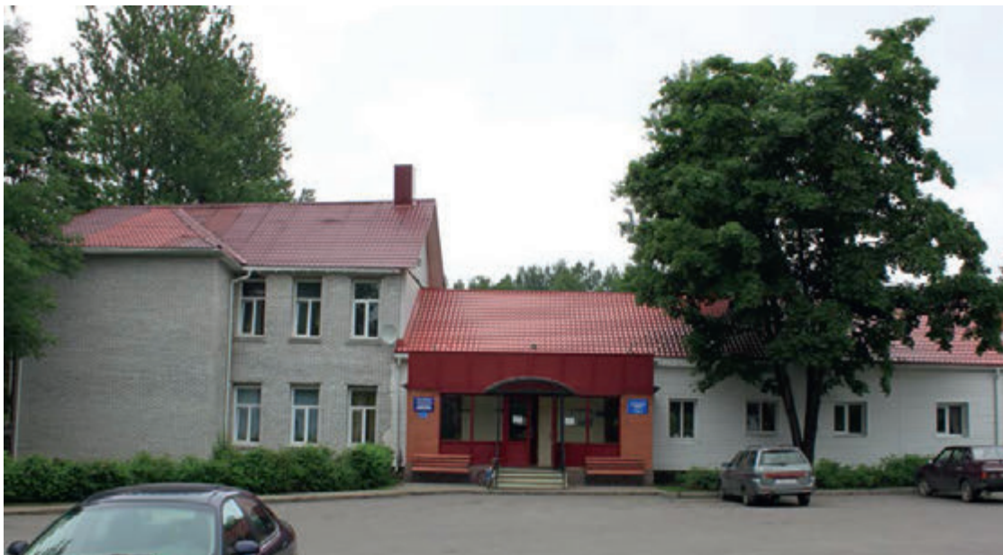
Здание ветеринарной станции Всеволожского района (2011 год)
