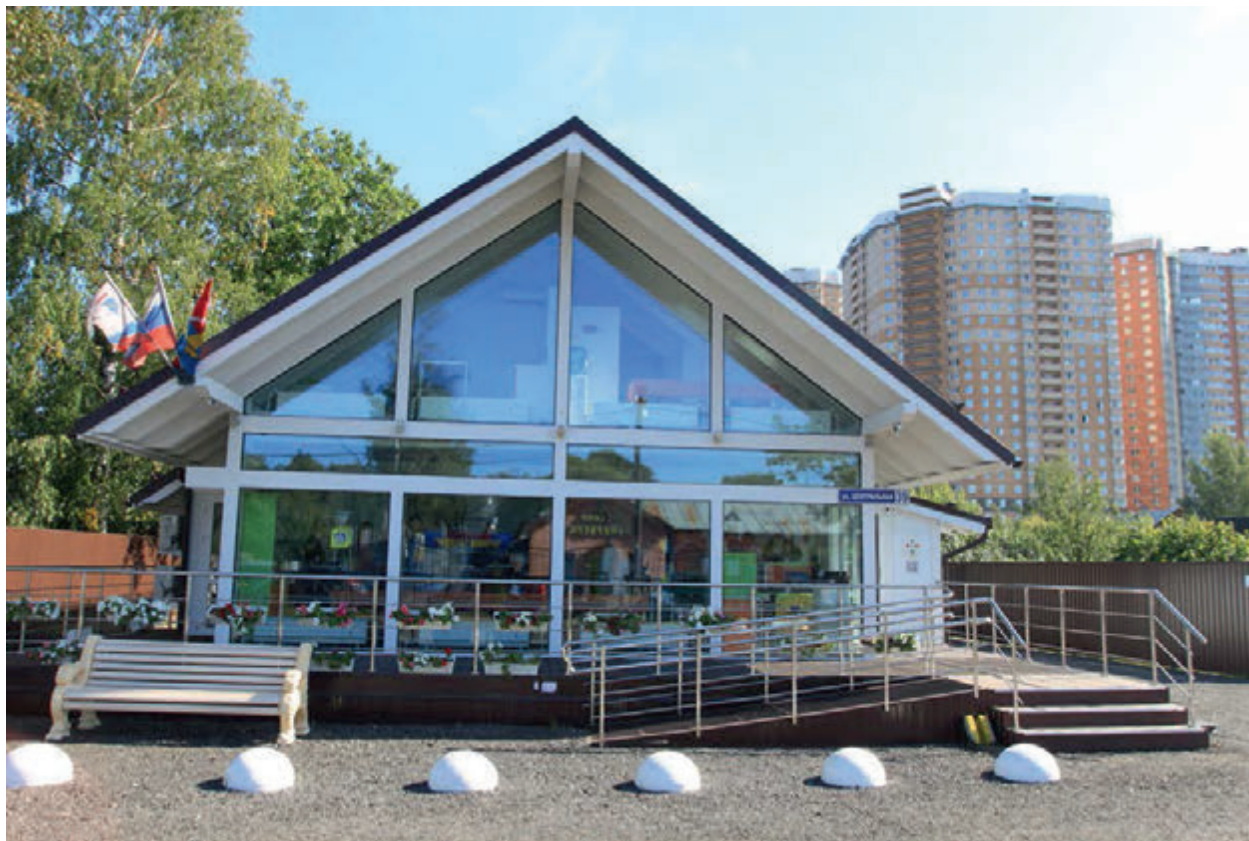
Построено здание Муринского ветеринарного участка (Всеволожский район)
