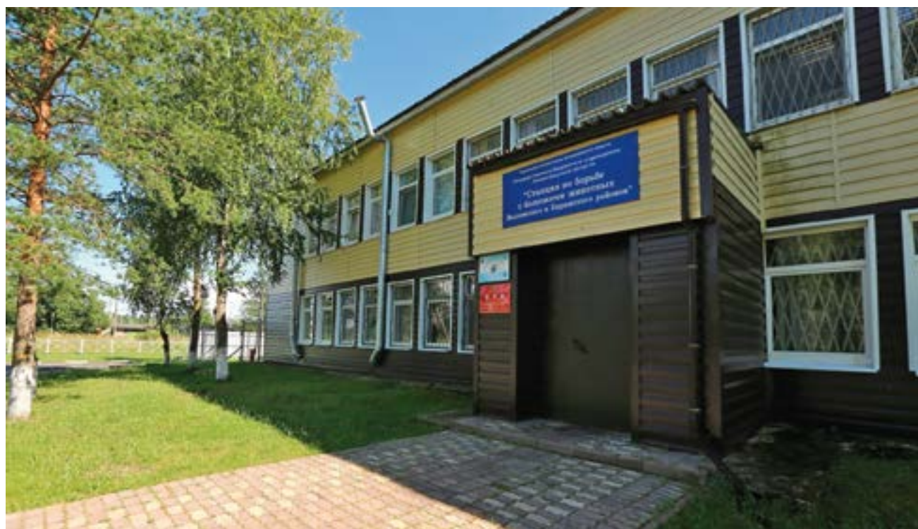
Здание ГБУ ЛО «Станция по борьбе с болезнями животных Волховского и Киришского районов», г. Волхов, 2020 г.
