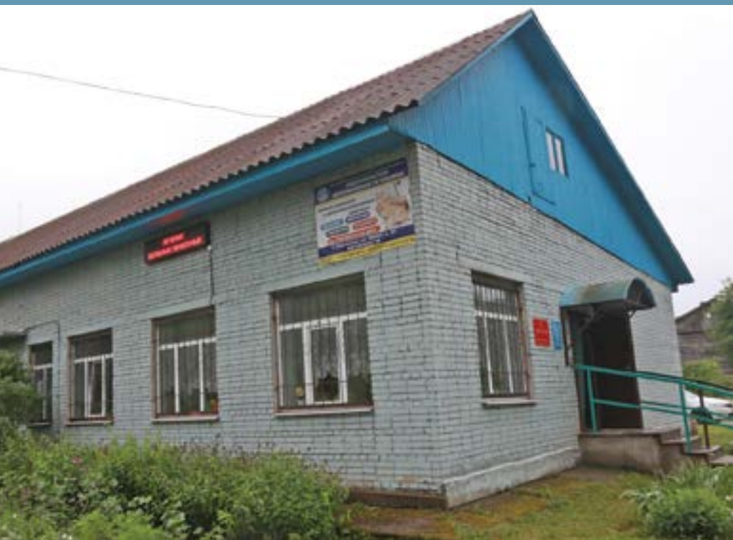
Здание Подпорожской ветеринарной лечебницы в г. Подпорожье
