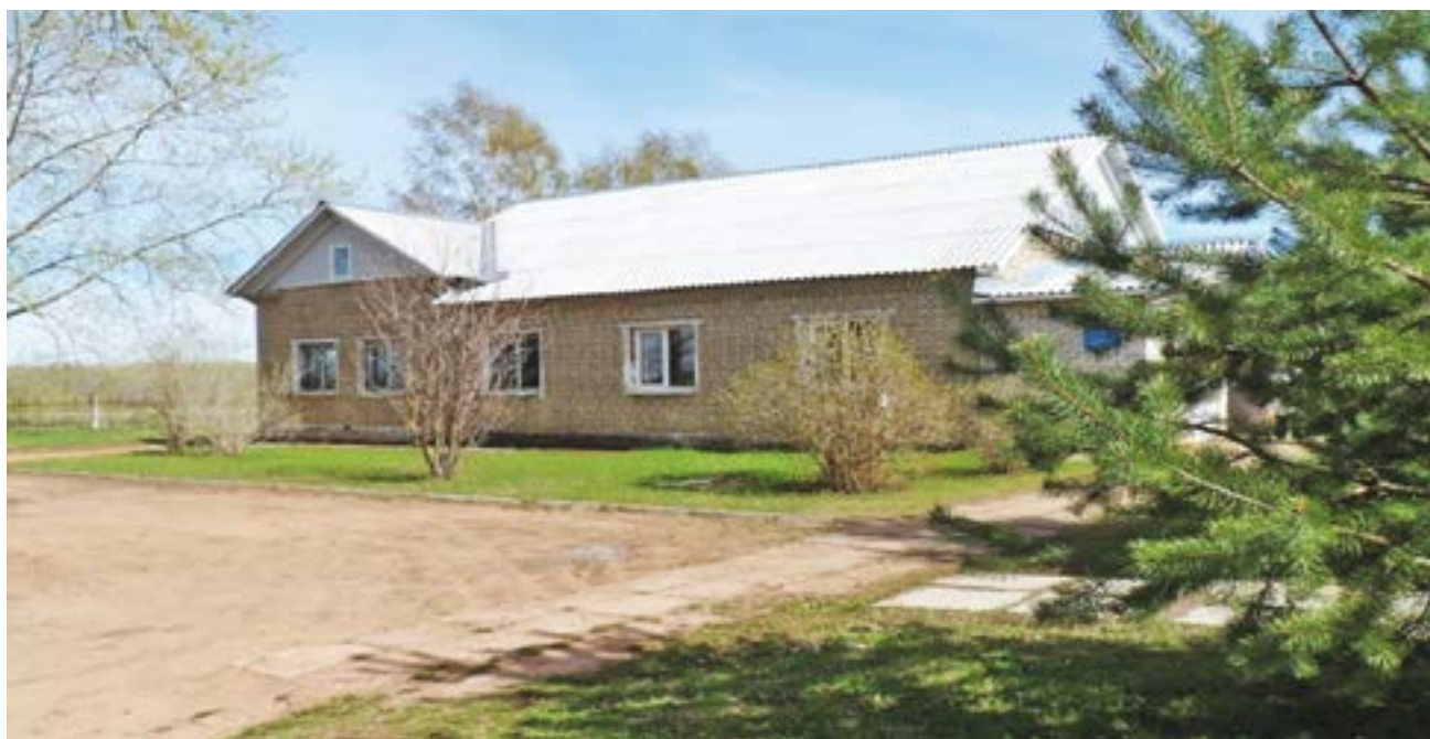
Здание Бокситогорской ветеринарной станции
