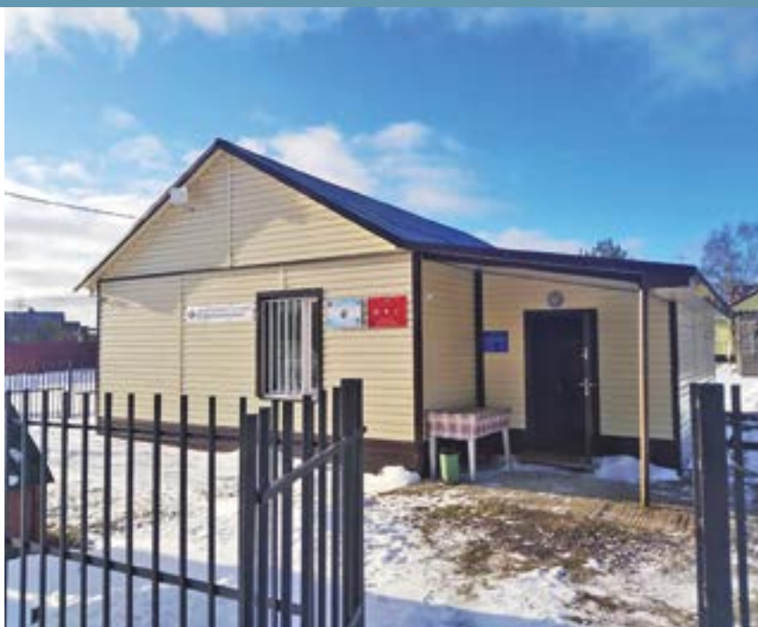
Здание Новоладожского ветеринарного участка, 2020 год
