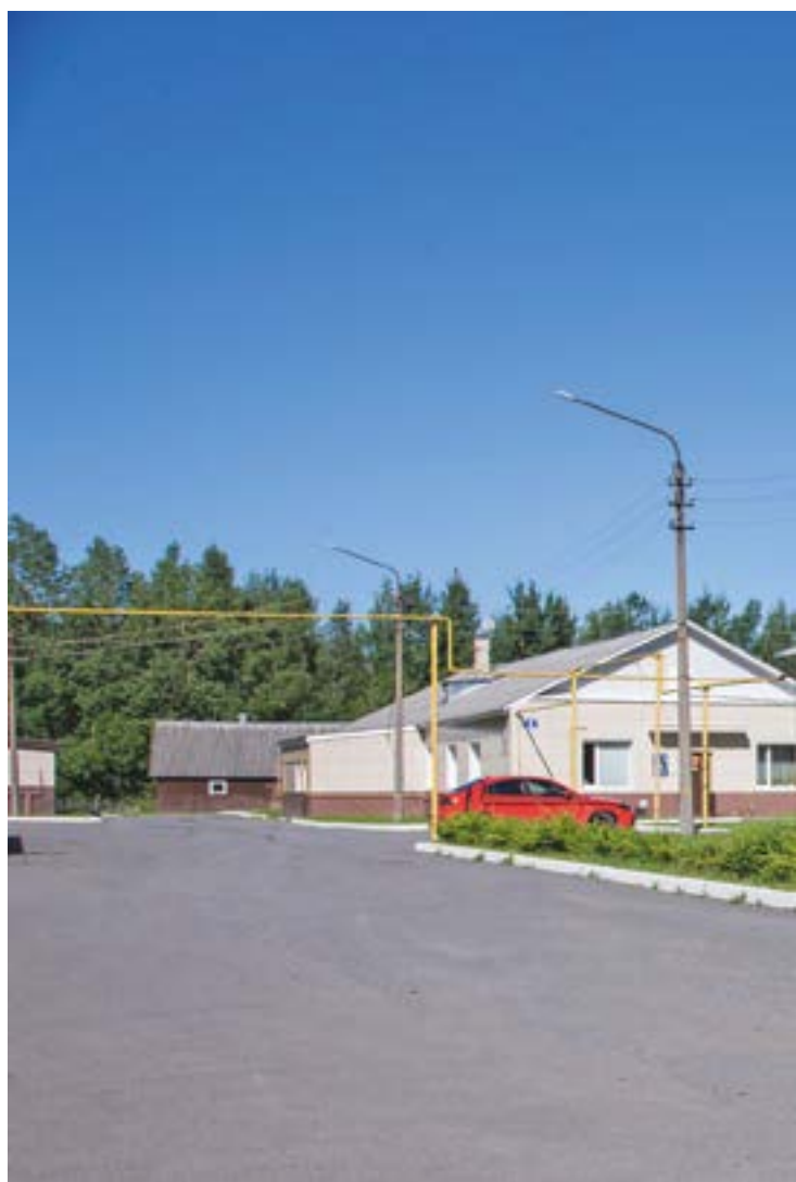
Здание Тихвинской ветеринарной станции
