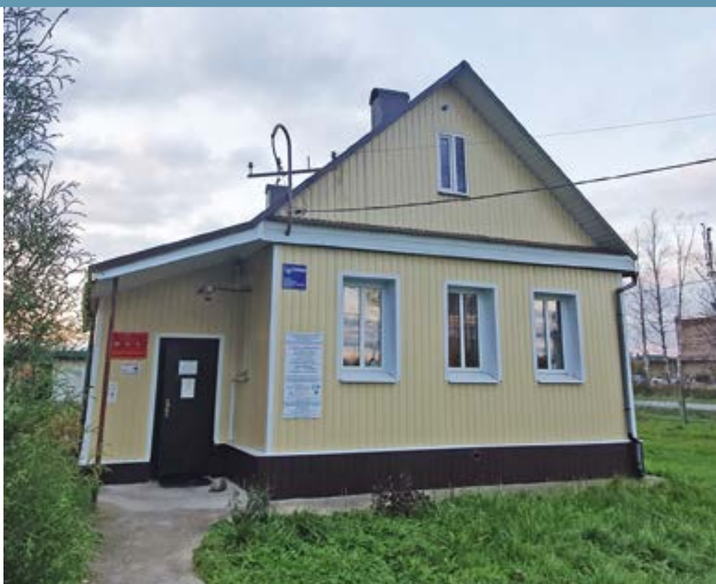
Здание Назиевского ветеринарного участка
