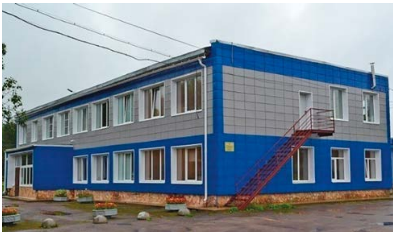
Здание ветеринарной станции после капитального ремонта
