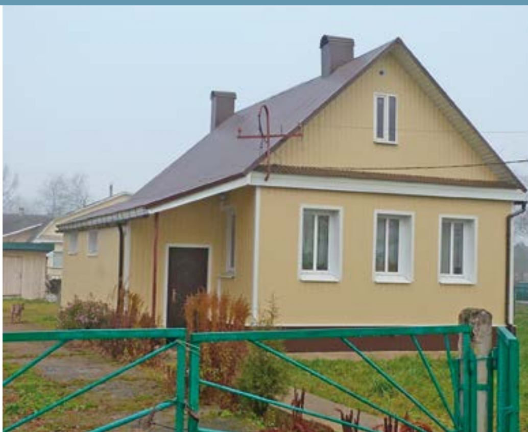
Здание Отрадненского ветеринарного участка
